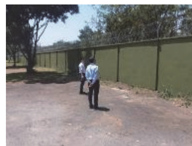
東西の新設壁と侵入防止ワイヤー
