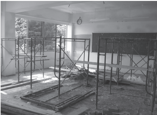
古い教室の取り壊しの様子
